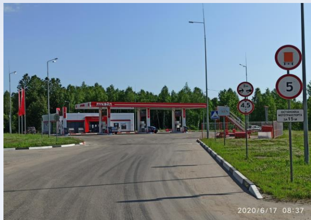
Автозаправочная станция «Лукойл» после реконструкции
