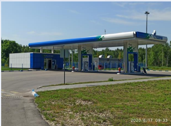
АГКНС-1 в районе села Морозовка
