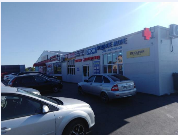
Торговый комплекс после реконструкции с площади 700 кв. м до площади 2000 кв. м
