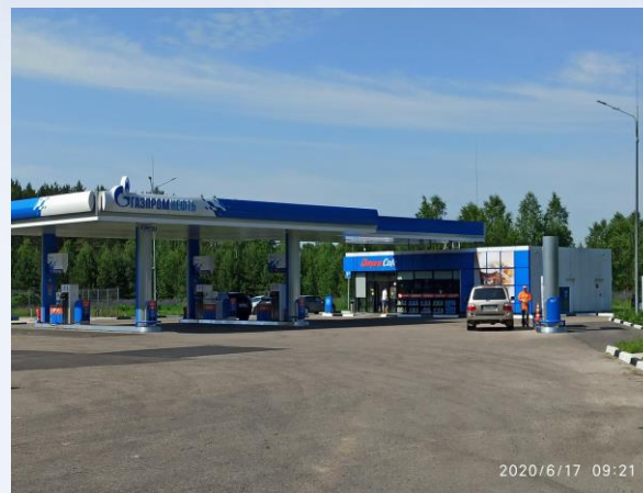
Автозаправочная станция «Газпромнефть» после реконструкции.
