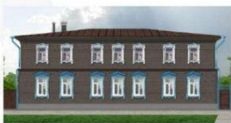
ул. К.Маркса, 11 (МКД) – идут работы,
