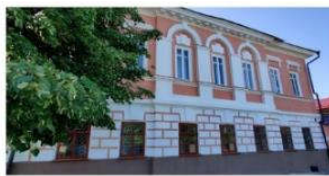
ул. Коммунистов, 10 (организация) – идут работы,
